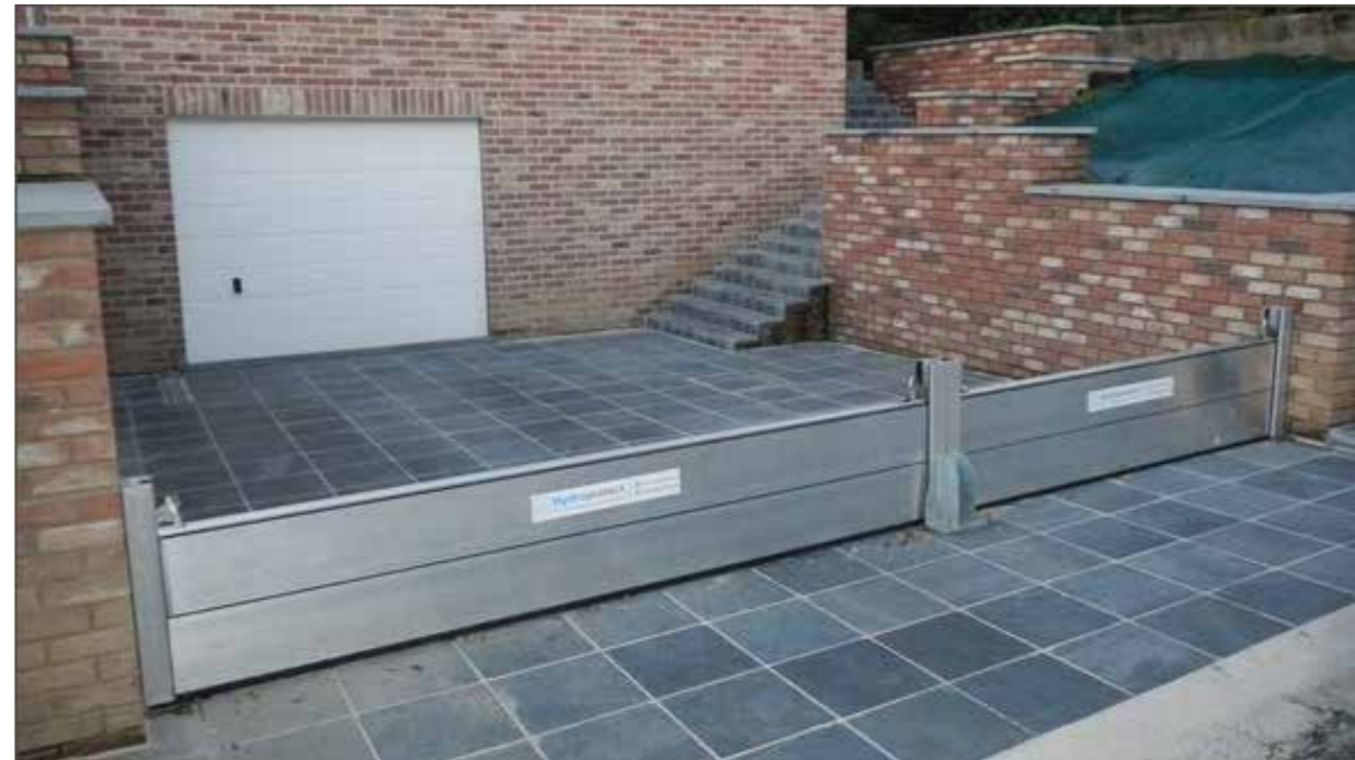
Description et fonctionnement des batardeaux
